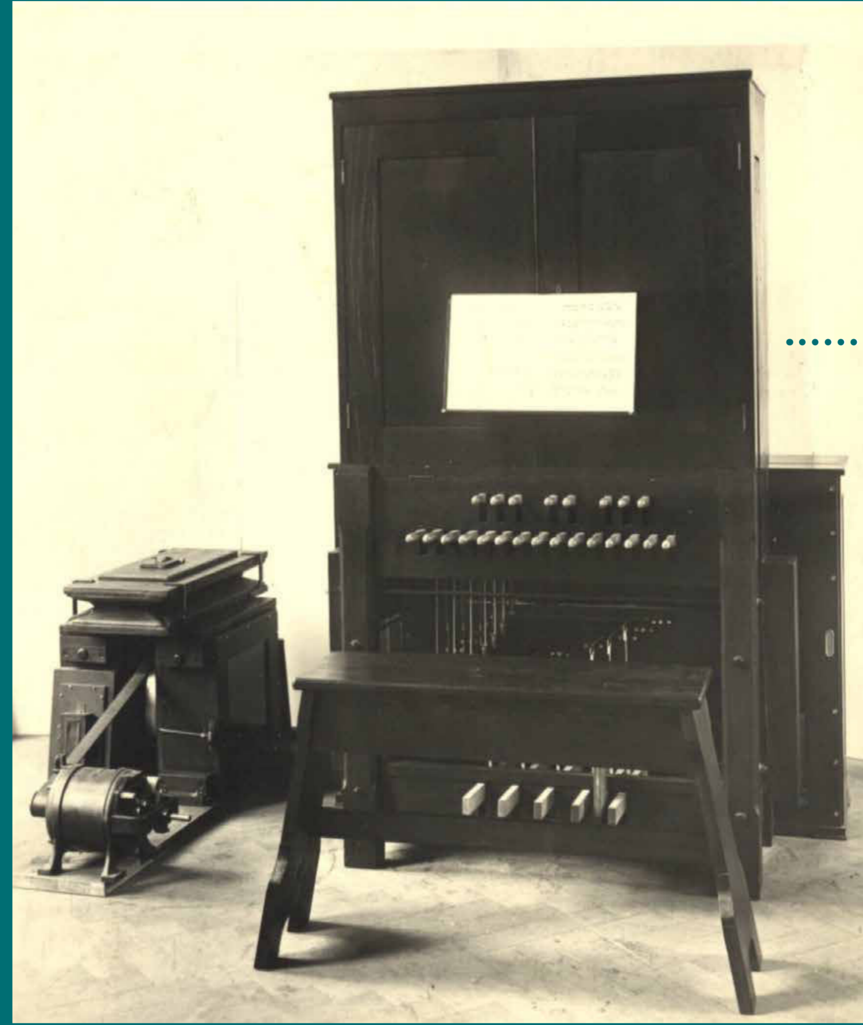
Werkfoto des Glockenspielapparates mit dem Gebläse
